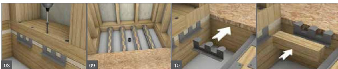
8. S'assurer que les supports en C sont montés de niveau (en supposant une plaque de base de niveau) et utiliser des vis autoperceuses à tête plate Phillips ailetées fournies par wedi. Fixer à travers la plaque de base et dans les deux (2) griffes métalliques reposant entre la plaque de base et le dessus du plancher en bois. Install one C bracket against the wall, and centered between each pair of floor joists.
